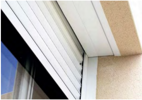
Exemple de caisson de volet roulant encastré : invisible de l'extérieur
