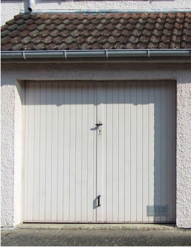
Porte d'origine en bois avec lambrisés verticaux couleur enduit
